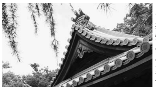
塩屋の荒神社(大嶋芥宮司)で今年1月から行っていた社殿改修工事がこのほど竣工した。
